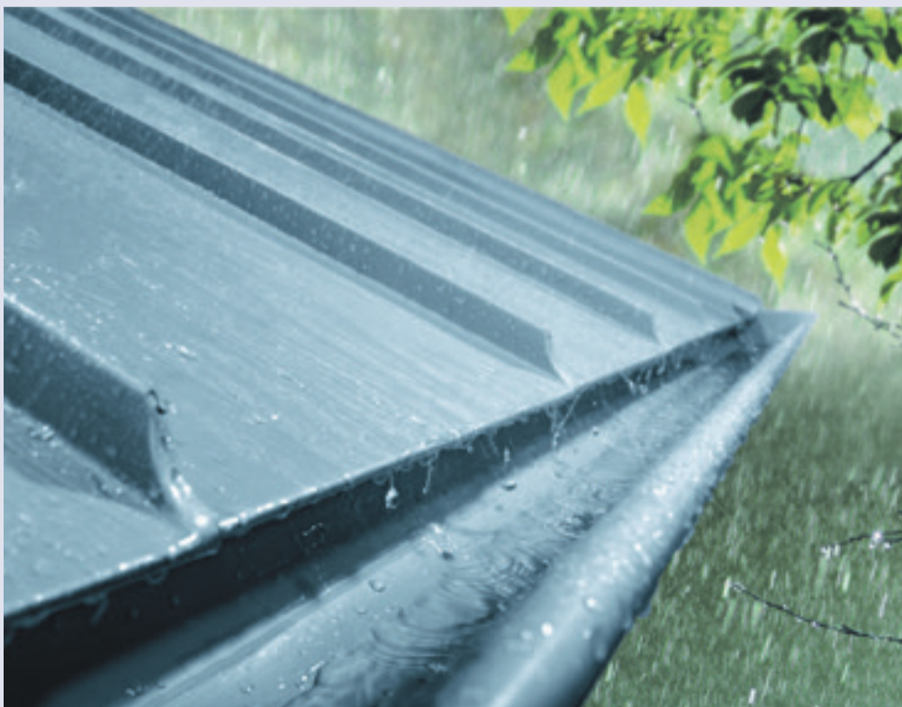
Dachdeckungen aus Titanzink sind optisch reizvoll und äußerst wetterfest.
