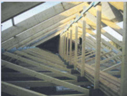
Nagelplattenbinder bieten ist eine optimale Alternative zum klassischen Flachdach.
