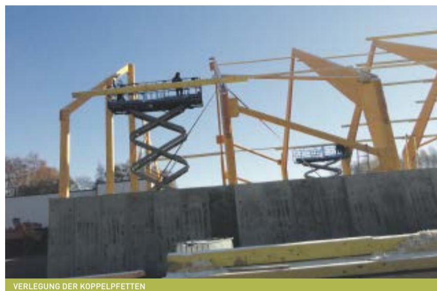
VERLEGUNG DER KOPPELPFETTEN
