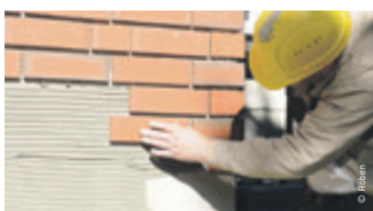
Auch VHF und klassischer roter Klinker sind vereinbar: mit Klinkerriemchen auf einer Putzträgerplatte
