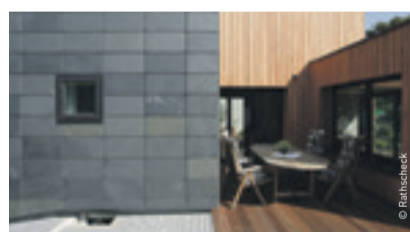
Spannende Fassaden-Kombination mit Schiefer in Rechteckdeckung und senkrechten Holzprofilen
