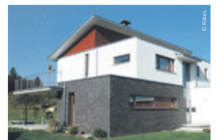
Eine Mischfassade – Verblendmauerwerk mit dunklem Farbspiel in Kombination mit Putz- und Holzoberflächen
