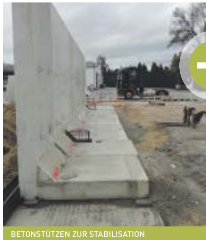
BETONSTÜTZEN ZUR STABILISATION
