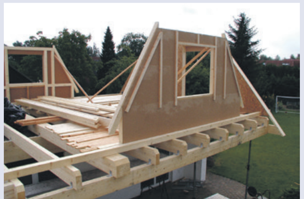
Mittels stabiler Holzbalkenanlage wird die Basis für eine weitere Etage geschaffen.
