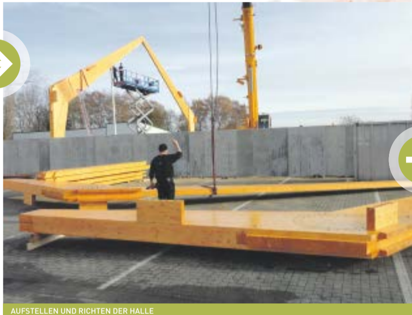
AUFSTELLEN UND RICHTEN DER HALLE
