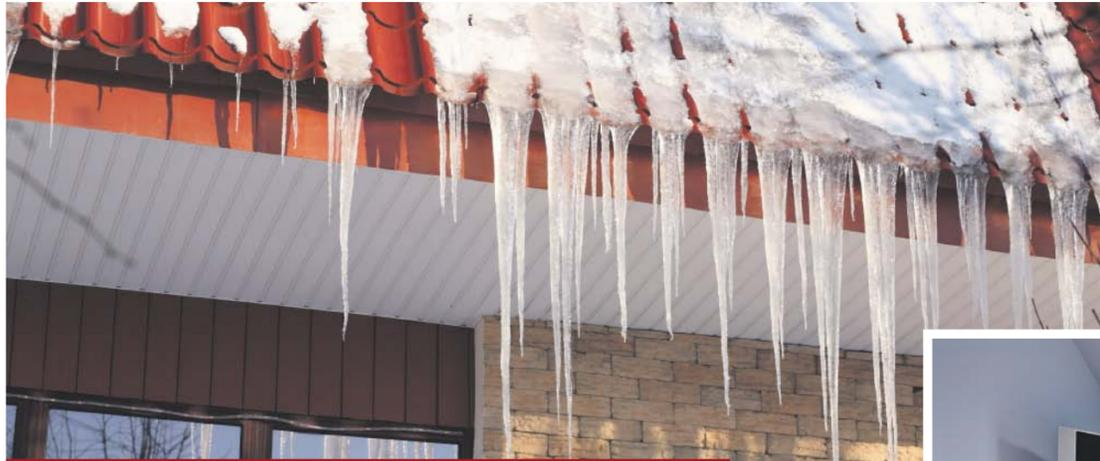
EINE GESCHLOSSENE SCHNEEDECKE AUF DEM DACH BEDEUTET EINE GUTE WÄRMEDÄMMUNG. EISZAPPEN SEHEN ZWAR GUT AUS, KÖNNEN ABER SIGNAL FÜR EINEN HOHEN WÄRMEVERLUST SEIN.
