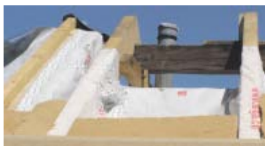
Holzfaserdämmplatten sind bei der Dachsanierung optimal geeignet.
