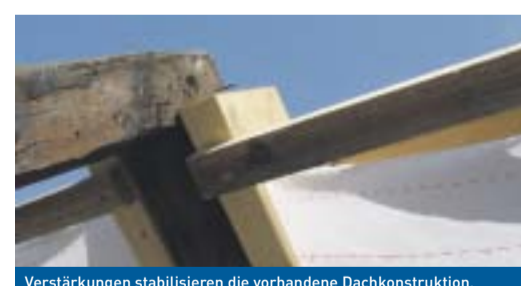
Verstärkungen stabilisieren die vorhandene Dachkonstruktion.
