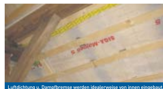
Luftdichtung u. Dampfbremse werden idealerweise von innen eingebaut.
