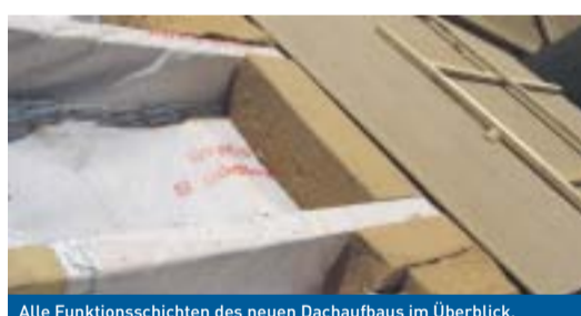
Alle Funktionsschichten des neuen Dachaufbaus im Überblick.
