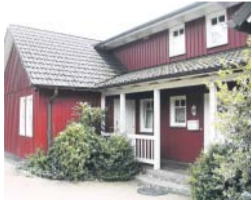
Inspiziert vom letzten Schwedenurlaub möchte sich unser Bauherrn-paar den Traum vom Holzhaus mit großzügiger Veranda erfüllen.
