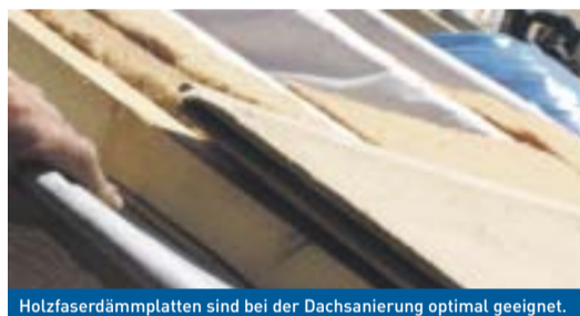
Holzfaserdämmplatten sind bei der Dachsanierung optimal geeignet.
