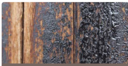
Epoche des chemischen Holzschutzes
