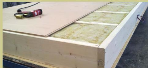
Entweder in der Werkhalle oder später auf der Baustelle wird das Rah- menwerk vollflächig ausgedämmt. Auf der Außenseite erhält das Wand- element eine Beplankung aus Holzfaser-Dämmplatten. Diese ist sowohl Zusatzdämmung als auch Unterdeckung für die spätere Fassadenbeklei- dung. Damit ist der **Feuchteschutz für die Außenwand gewährleistet.**
