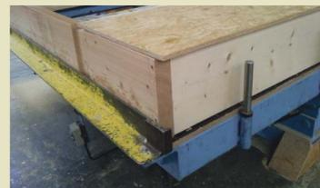
Von der Raumseite werden die Rahmen mit OSB- Platten beplankt. **Rahmen und Beplankung bilden eine statische Einheit und können enorme Lasten aufnehmen.** Zudem sind sie erdbebensicher. Dazu werden die Plattenstöße mit speziellen Klebbändern später luftdicht verklebt.
