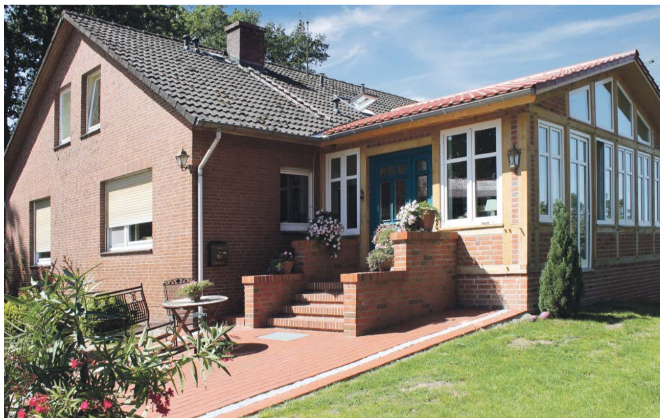
DER NEUE ANBAU IN HOLZRAHMENBAUWEISE WIRKT EINLADEND UND LÄSST VIEL LICHT INS HAUS.
