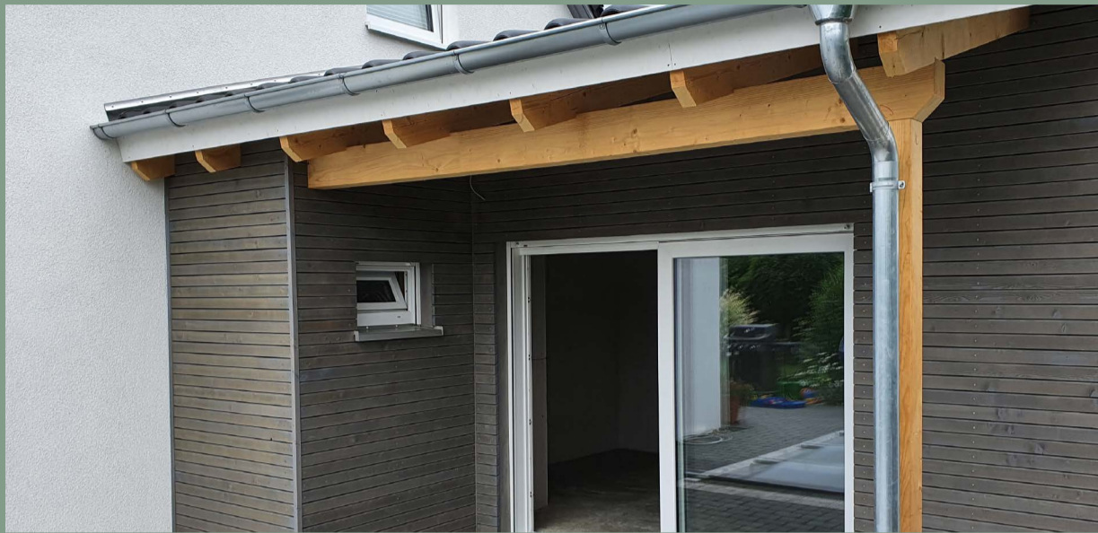
Mehr Wohnraum: Hier sorgte ein neuer Anbau in Holzrahmenbauweise für ein Plus an Wohnfläche.
