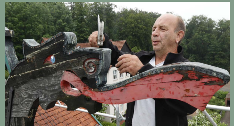
Schön alt: Kreativität und Geschick sind gefragt – wie bei der Sanierung von diesem reich verzierten Holzhaus.
