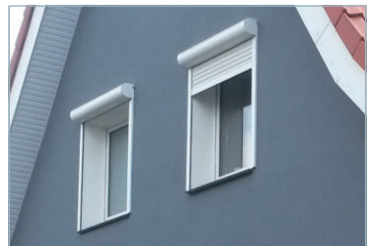
Die tiefe Fensterposition stört die Ansicht des Gebäudes erheblich. Hausbesitzer bereuen später diese Sparmaßnahme. Außerdem ist der Lichteinfall beeinträchtigt.
